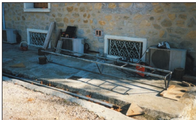
Photo n°1: Tronçon n°2 en cours de fabrication.
