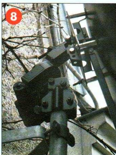
8 ... Cette plaque sera vissée sur le moteur horizon/horizon, placé en bout de tube. Il ne reste plus qu'à régler les trois angles caractéristiques : azimut, déclinaison, élévation.
