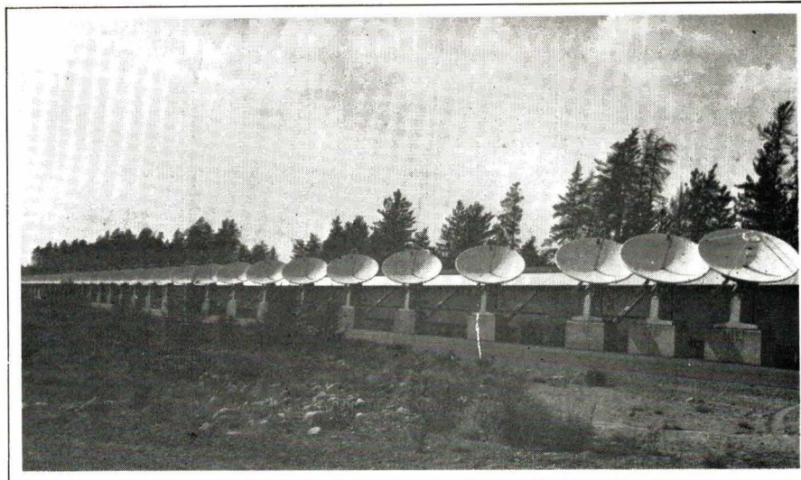
Fig. 19. – L'interféromètre à 32 réflecteurs paraboliques du Parc Algonquin (Canada). Ces antennes permettent entre autres de capter quotidiennement à midi les micro-ondes émises par le soleil et qui atteignent la terre (doc. CNRC).
