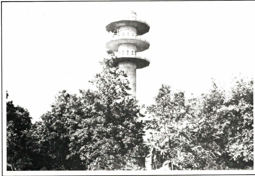
Photo 5. – Tour hertzienne du Mans. Cette tour, haute de 59 m, située sur la liaison Paris-Rennes, a été mise en service en 1973. Elle assurera la desserte du Mans par les liaisons Paris-Le Mans et Rennes-Le Mans. Les circuits de transmission de données de « l'autoroute électronique » de l'Ouest passent par cette tour (Cliché DTRN).
