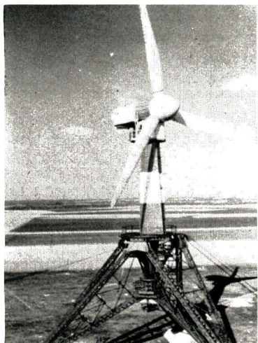
L'énergie éolienne : les pales ont 35 m de diamètre ! (aéro-générateurs expérimentaux).
